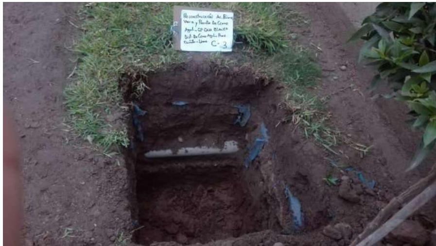
FOTOGRAFIA 1: EXPLORACION DE CALICATA
