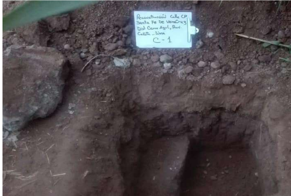
Calicata N°1 PUENTE SANTA FE DE VERACRUZ 1
